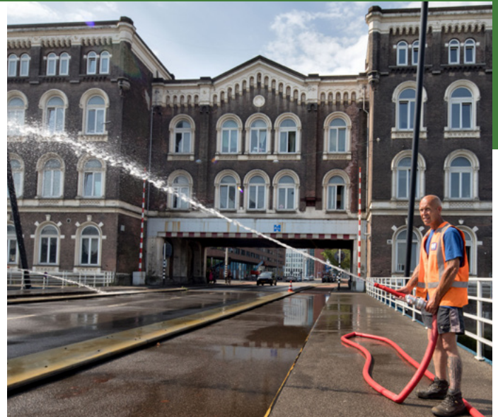
Hittestress, Binnenhavenbrug wordt gekoeld.
